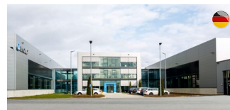
ARNOLD UMFORMTECHNIK Dörzbach Germany
