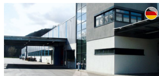
ARNOLD UMFORMTECHNIK Ernsbach Germany
